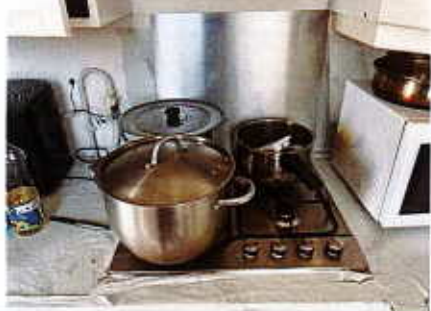
Photo n° PhGaz001 Localisation : Cuisine Table de cuisson Sans marque apparente (Type : Non raccordé)
